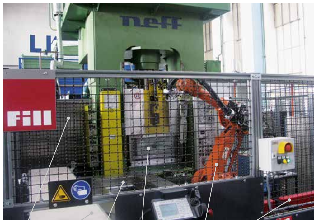
Regelstrecke Stickstoff Transportband Wanne zum Blechvorkühlen 160to Presse/ Werkzeug Steuerung Transferroboter Platinenmagazin Automatisierte kryogene Presslinie in Ranshofen
